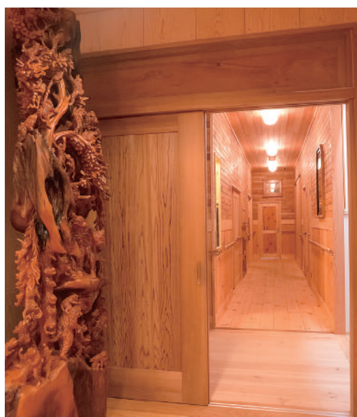
台所 出入口 戸:屋久杉
